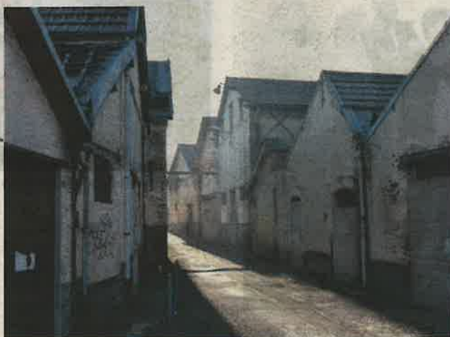
À Longueville, le projet de réhabilitation de la friche industrielle devrait être officiellement lancé en 2024. Le début des travaux de démolition est espéré d'ici à la fin de l'année RSM77
