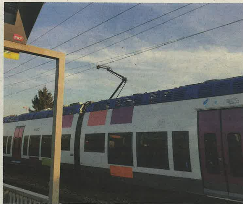
En gare de Provins, les trains de la Ligne-P roulent désormais à l'électrique. 3 200 poteaux caténaires ont été posés pour permettre l'électrification totale de la branche Paris-Provins DR
