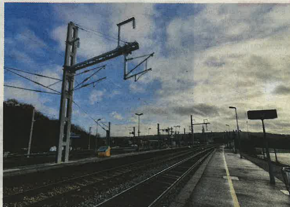
Après 3 ans de travaux, la branche Paris - Provins - Nogent/Seine de la Ligne P est totalement électrifiée. Comme ici, en gare de Longueville, 3 200 poteaux caténaires ont été posés CH/RSM77
