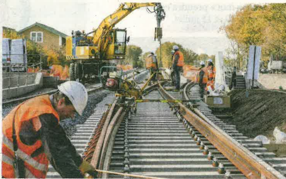
Cet été, le trafic de la branche Paris-Provins de la ligne P va être modifié par des travaux qui se dérouleront sur plusieurs week-ends ©SNCF
