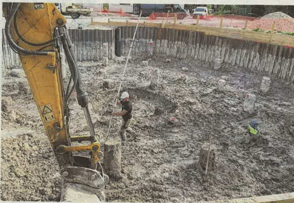
La nouvelle structure sera située à côté de l'ancienne, rue la Martine
