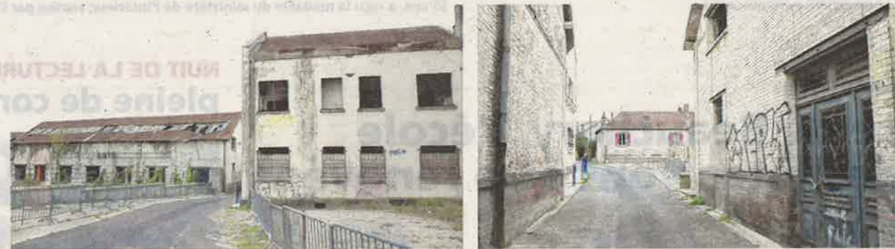
En 2019, la construction de la station d'épuration (en haut) et l'avenir de la friche industrielle (en bas), seront les deux grands projets menés par la Ville
