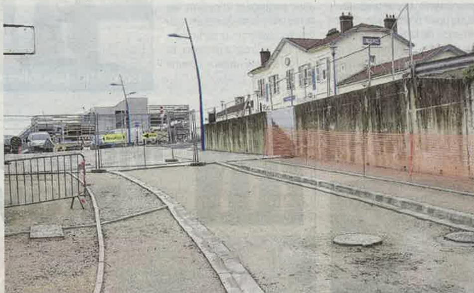
Les travaux rue de Verdun doivent se terminer pour le 20 janvier.
