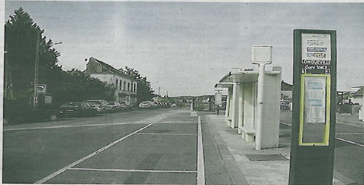
Emplacements de cars aux abords de la Gare de Longueville.
