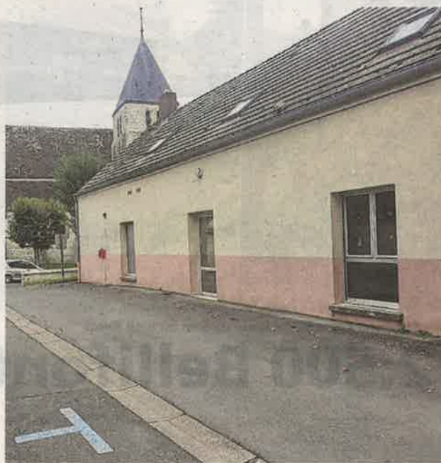
Le bâtiment qui va accueillir l'antenne de la maison de santé existe déjà ©CH/RSM77
